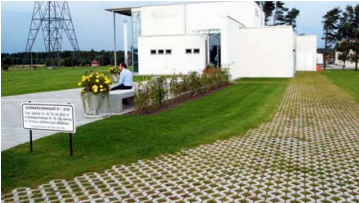
Figur 12. Gräsarmering i betong (S:t Eriks).
